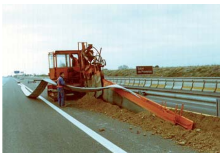
Obr. 33: Instalace kompozitní drenáže jako drénu krajnice
